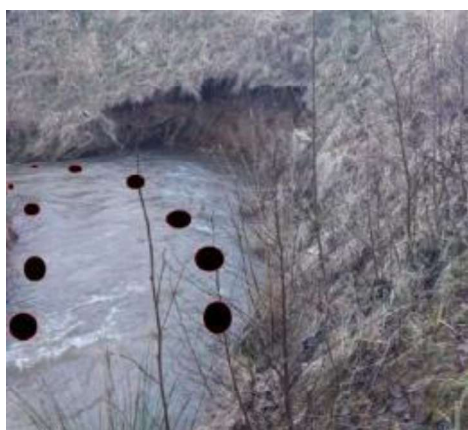
Figur 17: Inden flowstyring er der stor brinkerosion. Sorte cirkler angiver hvor store sten kan placeres til flowstyring (foto: Torben Tran Ankærø).
