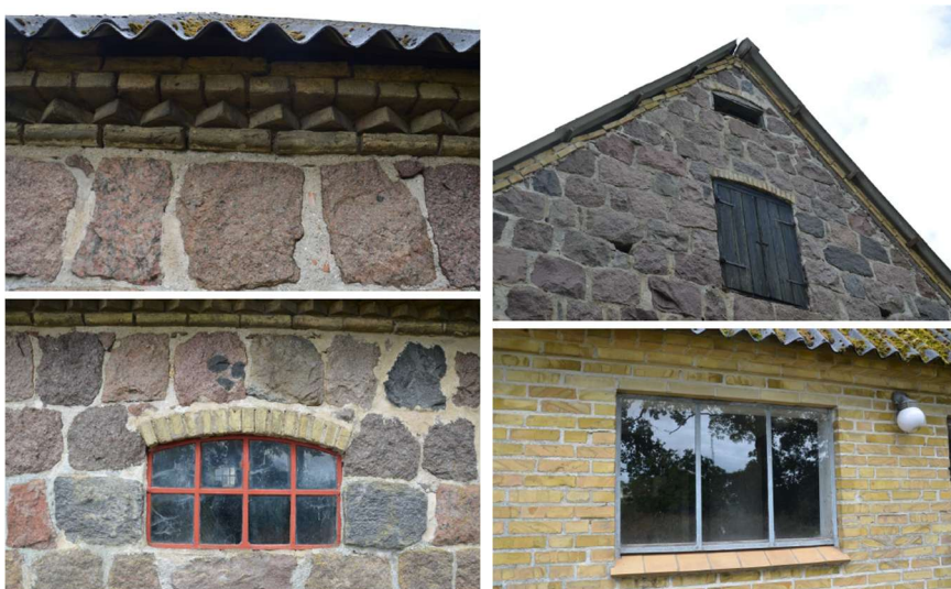
Bygningsdetaljer – Lunderødvej 64, 4340 Tølløse, 2025
