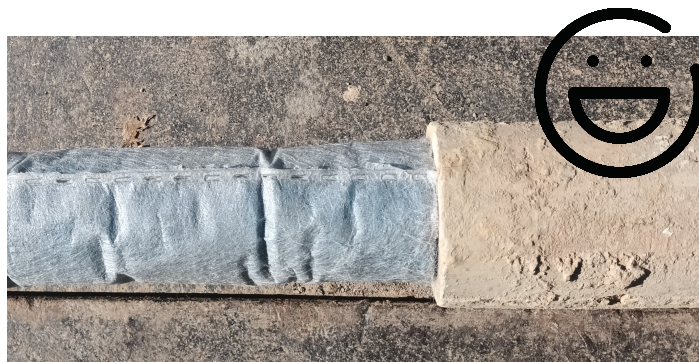
Den færdige reparation for porøse lerrør
