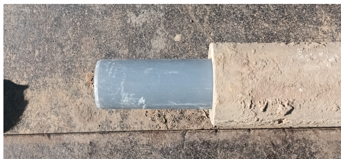
Plastrør indsat ca. 15 cm i eksisterende lerrør
