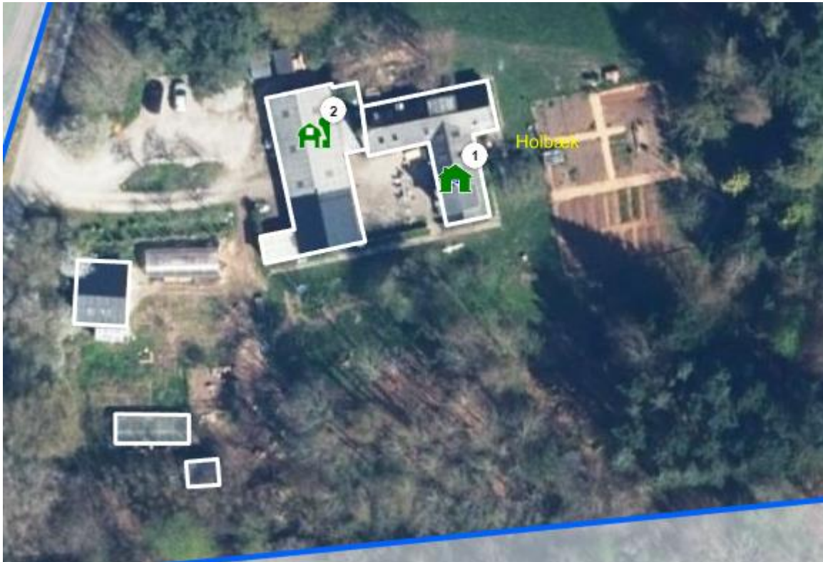
Figur 5 viser bygning 1 og 2, jf. BBR. Polytunnellen ses vest om bygning 2.
