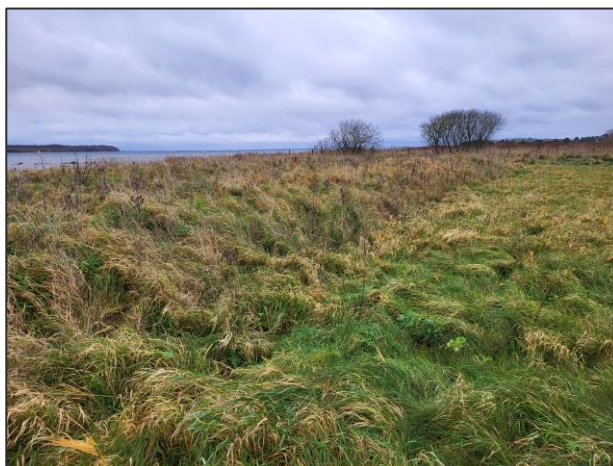
Figur 2.4: Foto af dige ud for Tokkernegen og Engbovej. Foto taget d. 14/11-2023 under inspektion.
