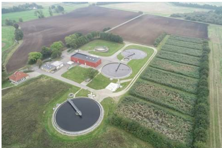
Tysinge renseanlæg: Slammineraliseringsbedene ses til højre i fotoet.
