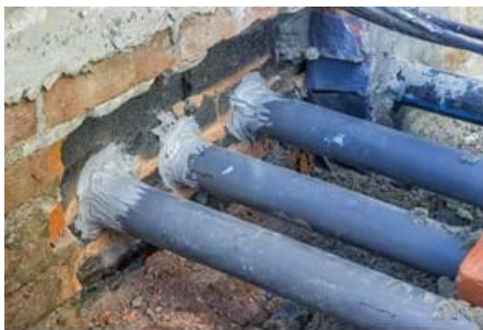
Sikring mod rotters indtrængen
