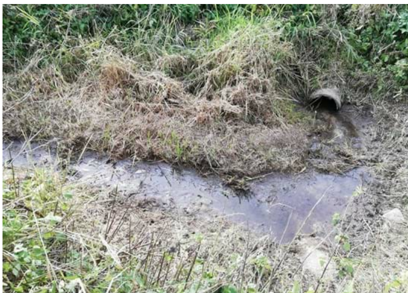
Eksempel på rørudløb til Bårupgrøften nord for Kirke Eskilstrup
