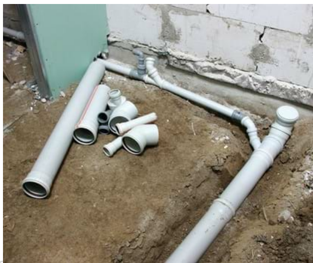
Udskiftning af kloakrør i hus
