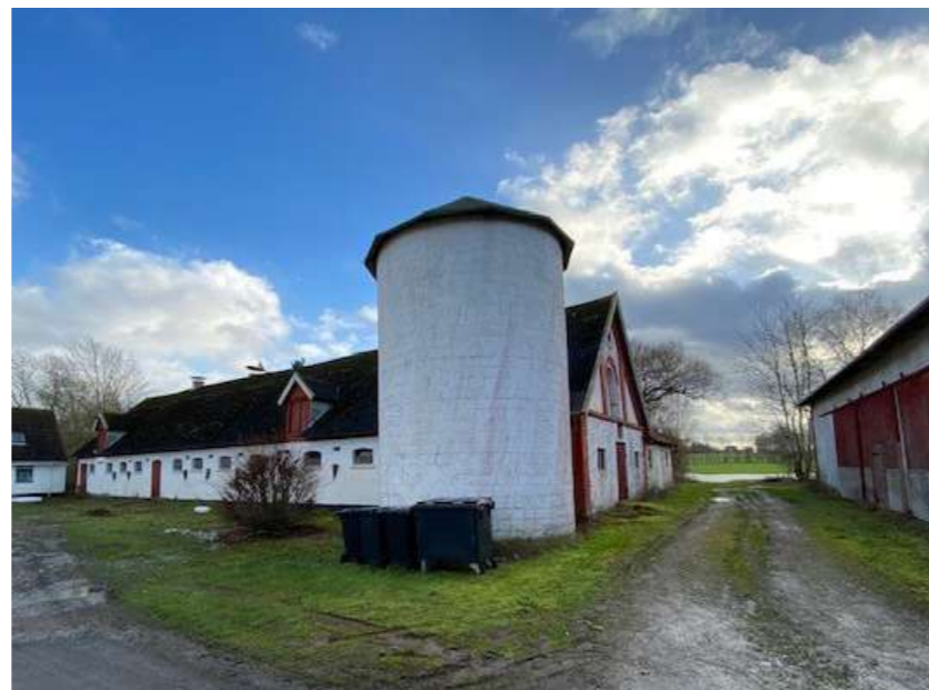
Den centralt beliggende properitærgård Lille Frydendal, har en kulturhistorisk værdi. Bygningerne har en middel bevaringsværdi (SAVE 5). Kilde: landskabsregistrering og -analyse_Helhedsplan Holbæk Vest (1)
