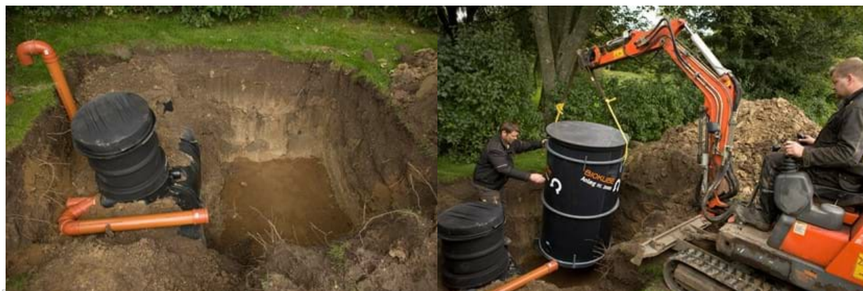
Eksempel på minirenselanlæg under etablering
