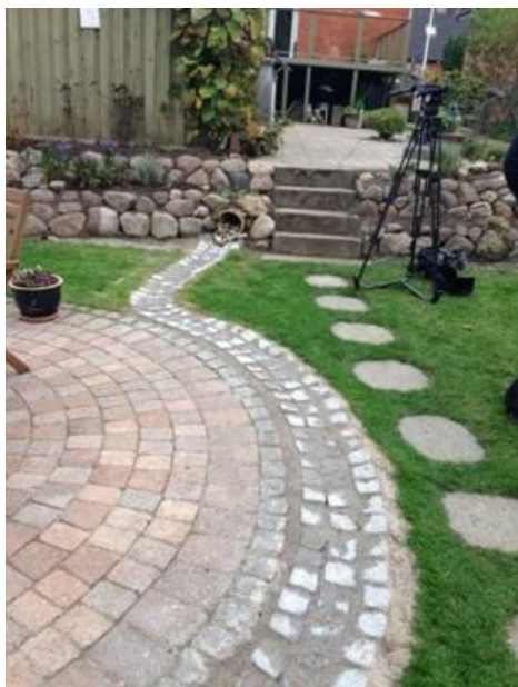
Eksempel på en LAR-løsning: Regnvandsrende
