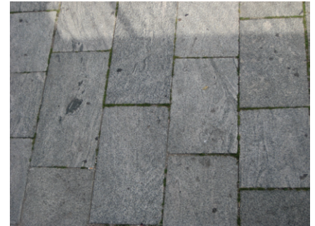
Figur 33: Permeabel flisebelægning i Ørestaden København. Regnvandet kan sive ned gennem belægningens fuger. Foto Orbicon.
