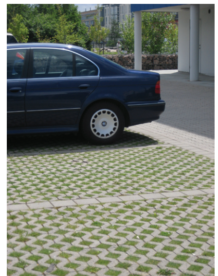
Figur 35: Permeabel græsarmering på parkeringsplads i boligområdet B001 i Malmø Västra Hamn. Græsarmering sikrer både nedsivning og fordampning af regnvand. Foto Orbicon
