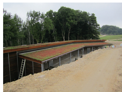
Figur 29: Sedumtag, Ree dyrepark. Foto Orbicon
