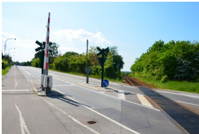
Jernbanen krydser Kalundborgvej.
