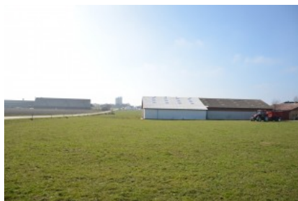
Større landbrugsbygninger ved Gislinge.
